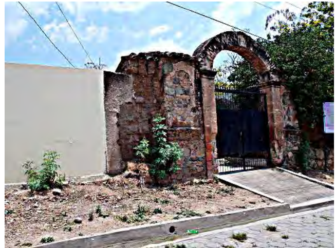
Ruinas de la iglesia colonial
