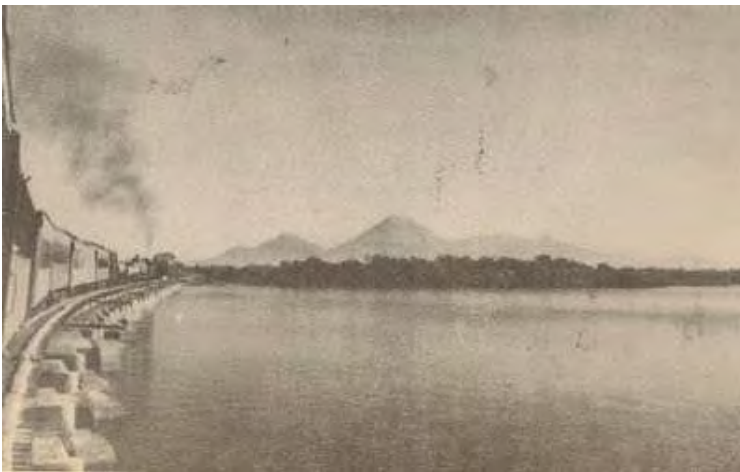
Foto 1 Puente ferroviario de Pasocaballos construido en 1880, durante el “Período de los Treinta Años Conservadores”, fue la primera unión del Puerto de Corinto con tierra firme.
