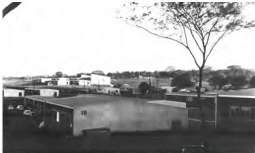
Recinto Universitario “Rubén Darío” de la UNAN-Managua, construido, en su primera etapa, en 1968, durante la rectoría del Dr. Carlos Tünnermann Bernheim.
