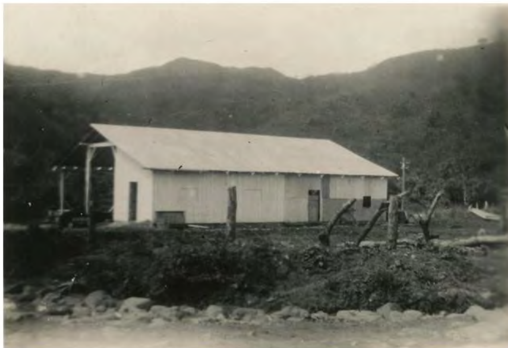
Palnta eléctrica de Matagalpa
