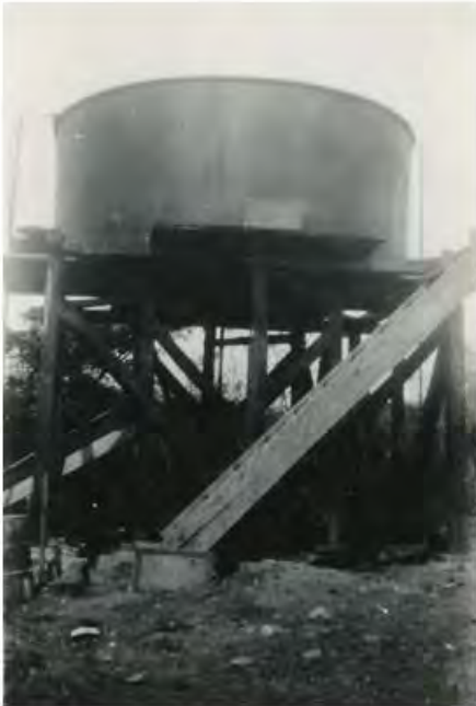
Tanque de agua de la planta eléctrica de Mtagalpa
