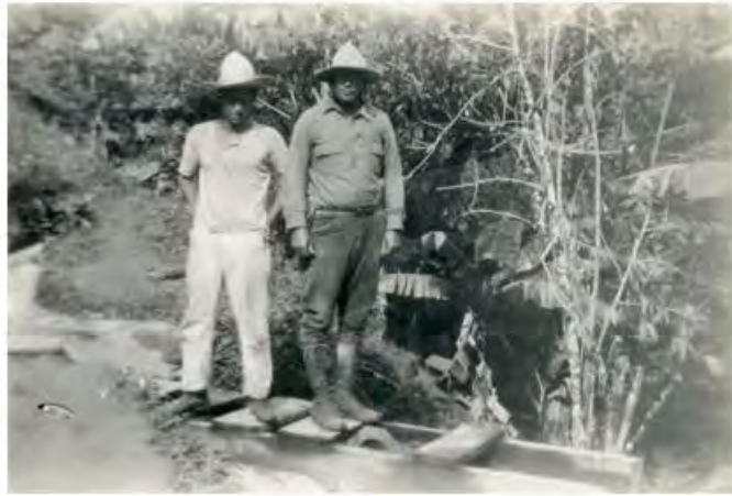
Empleados de la planta eléctrica de Mataglapa
