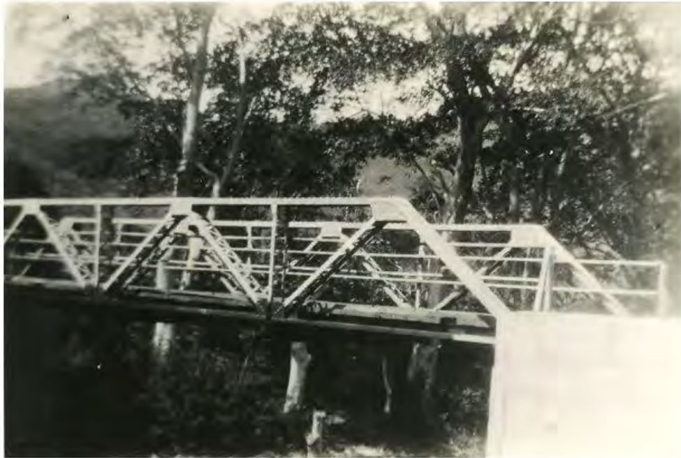
Puente sobre el río Matagalpa a la entrada de la ciudad de Matagalpa
